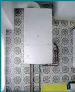
El inspector comprobará la correcta combustión de las calderas, calentadores y vitrocerámicas a gas,(1) asegurando que el nivel de monóxido de carbono presente en los gases de la combustión no supere los límites permitidos.
