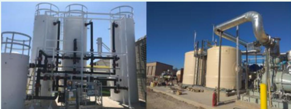
Ilustración 31. Sistemas de desulfuración mediante carbón activo. Imágenes cedidas por Bioconservación
