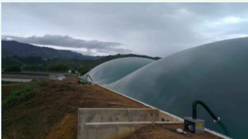
**Ilustración 19. Ejemplo de balsa con cubierta flotante.** Fuente: Membrane Systems Europe BV.
