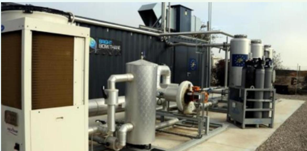
Ilustración 27. Planta de producción de biometano por membranas en VILA-SANA. Fuente: Sedigas
