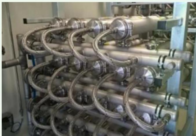
Ilustración 33. Módulo de membranas. Fuente: Bright Biomethane
