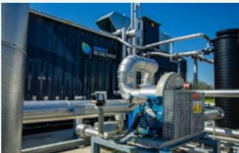
Ilustración 30. Sistema de enfriamiento del biogás. Fuente: Bright Biomethane
